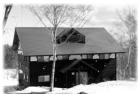
竣工したの森のフリースクール「いのちの森の学校」（建物名：森のしずく）
